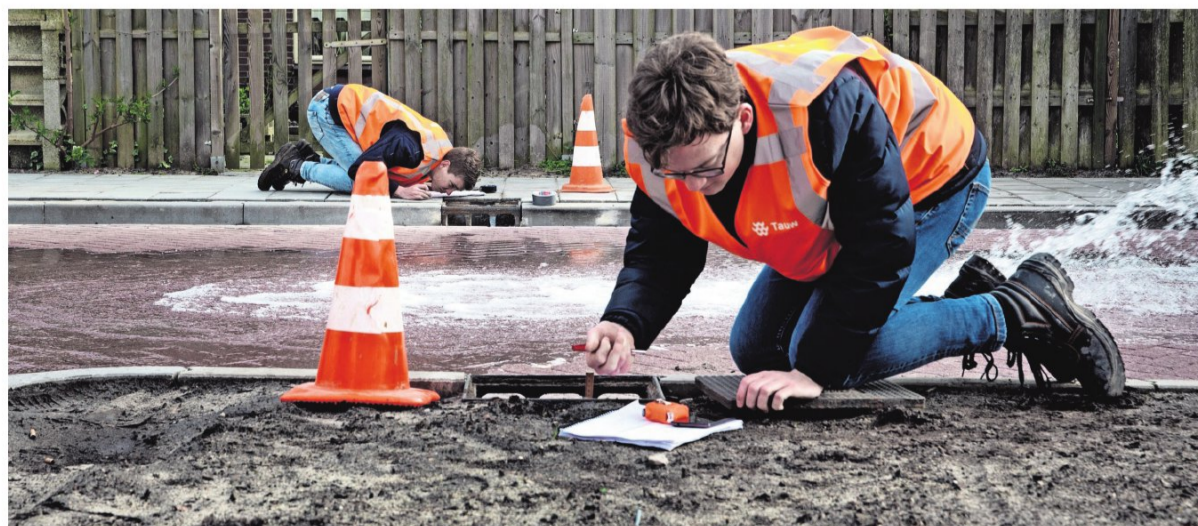
Studenten en medewerkers van Tauw meten nauwkeurig hoe snel het water van het wegdek verdwijnt.
